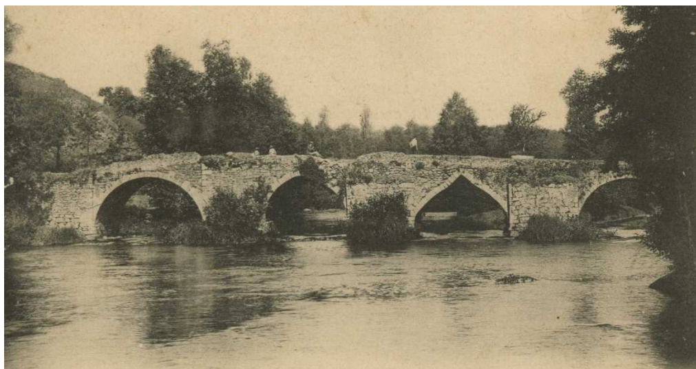
Vue aval du pont à la fin du XIX ème siècle avant l'effondrement.
