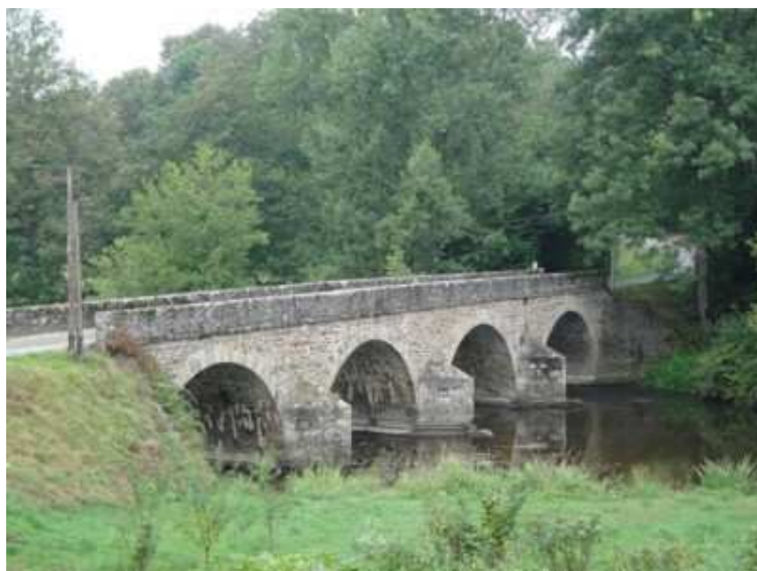
Vue amont du pont actuel avec les avants becs.
